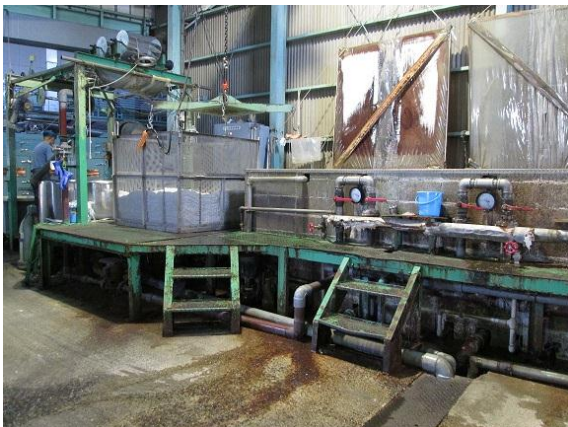
手前が翹抜き槽、奥がバスケットに入れたタオル生地
