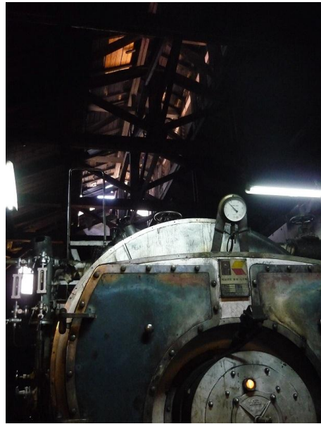
1963年製ボイラーを守るための木製の屋根
