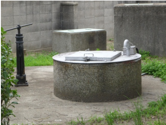
「蔵敷水源地」施設内にある取水井戸（通称、糸染め井戸）
